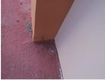
c) Binada dış cephe kolon zemin birleşimi
