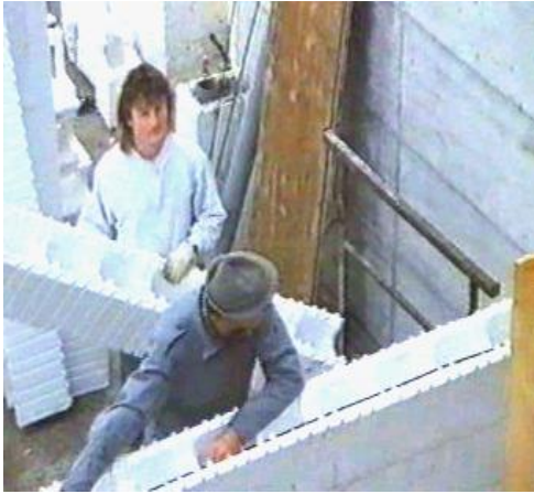
Şekil 1. EPS YKDBT Duvar Sisteminin Uygulanışı (Anonim)
