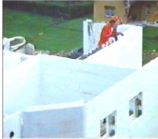
Şekil 1. EPS YKDBT Duvar Sisteminin Uygulanışı (Anonim)
