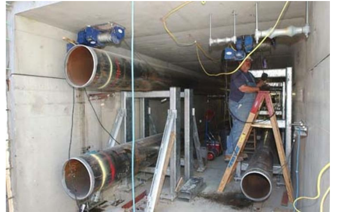
Şekil 3. United States Capitol Visitor Center Utility Tunnel iç görünüş (Capitol Visitor Center Project Office, 2005).
