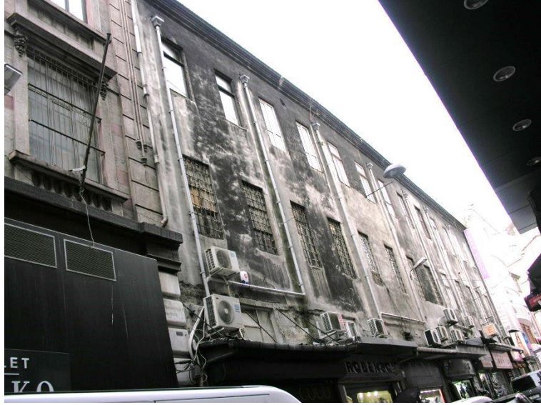
Fotoğraf 7-Kuzey cephesi.
