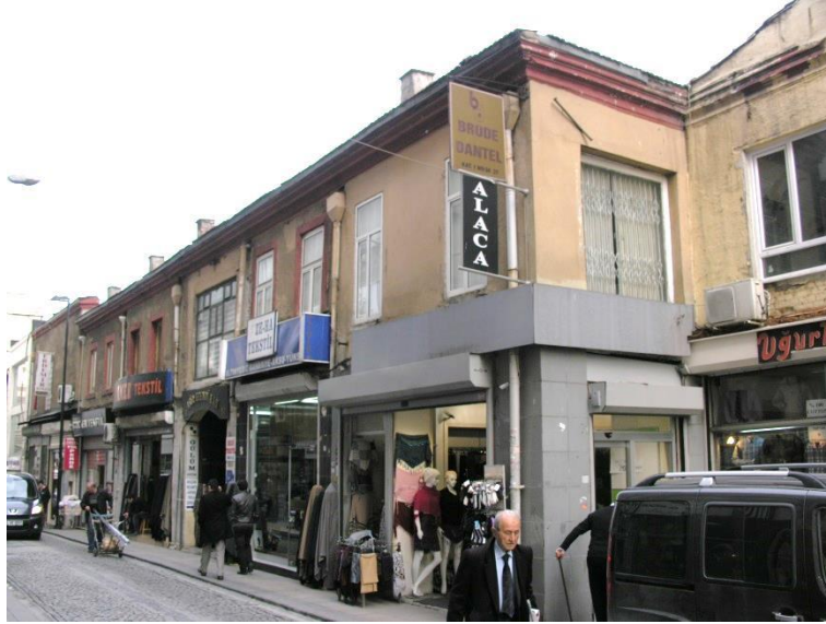
Fotoğraf 6-Güney cephesi.
