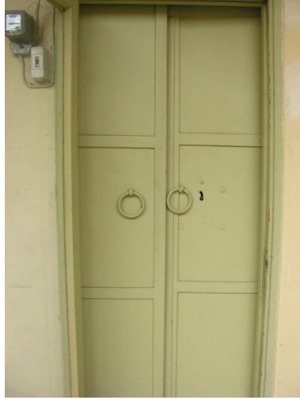
Fotoğraf 17- 2.kattaki dökme demir kapı kanatlarından bir örnek
