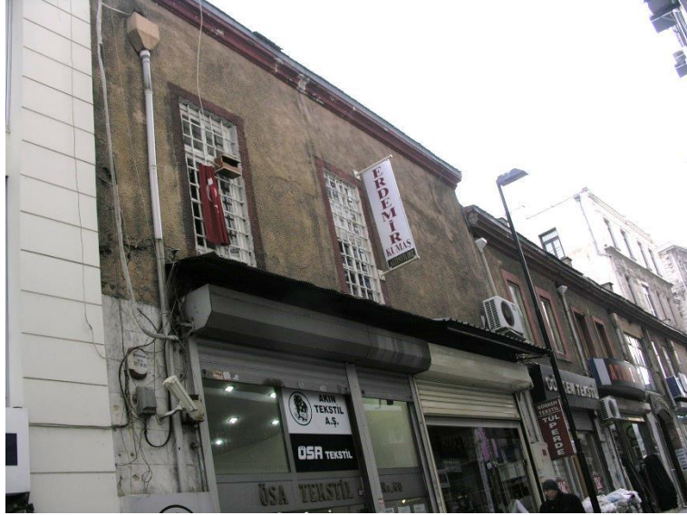
Fotoğraf 8-Güney cephesinin batı kesimi.
