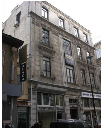
Fotoğraf 3 -Ankara Konya Hân. Güney cephesi.
