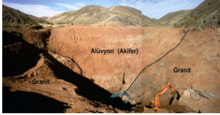
Şekil 3. Kırıkkale-Yahşihan Yeraltı Barajı gövde kazılarında görünüm [10]
