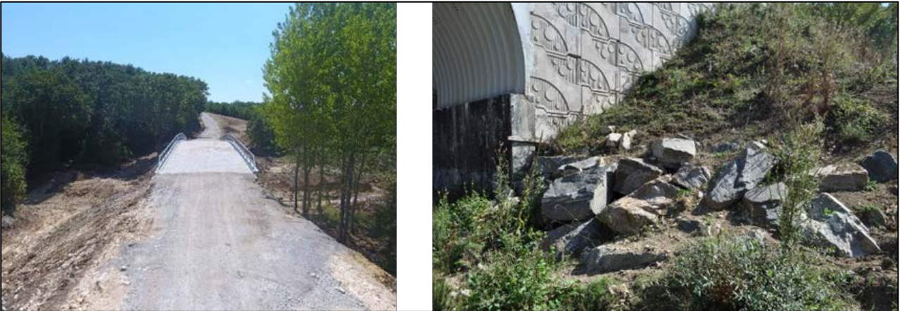
Şekil 11. Köprü yaklaşım dolgusunun ve taş blokajların hazırlanması
