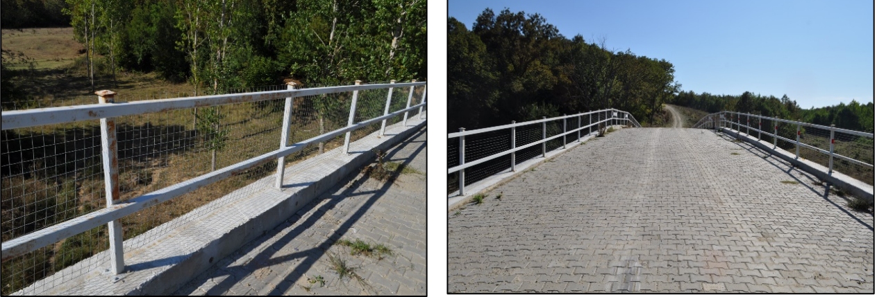
Şekil 10. Çelik köprü korkulukları ve kilit taşı malzeme ile köprü üst yapısının oluşturulması
