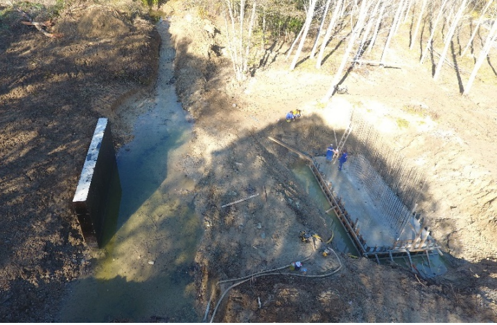
Şekil 4. Çelik köprü temel ve kenar ayaklarının betonarme olarak inşası
