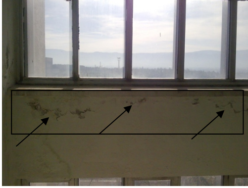
Şekil 3.7: Parapet bölgesinde görülen yoğuşma sorunu
