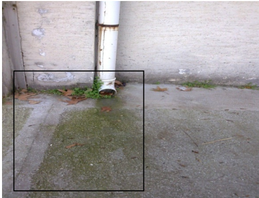
Şekil 3.19: Oluşan çiçeklenme ve yosunlama
