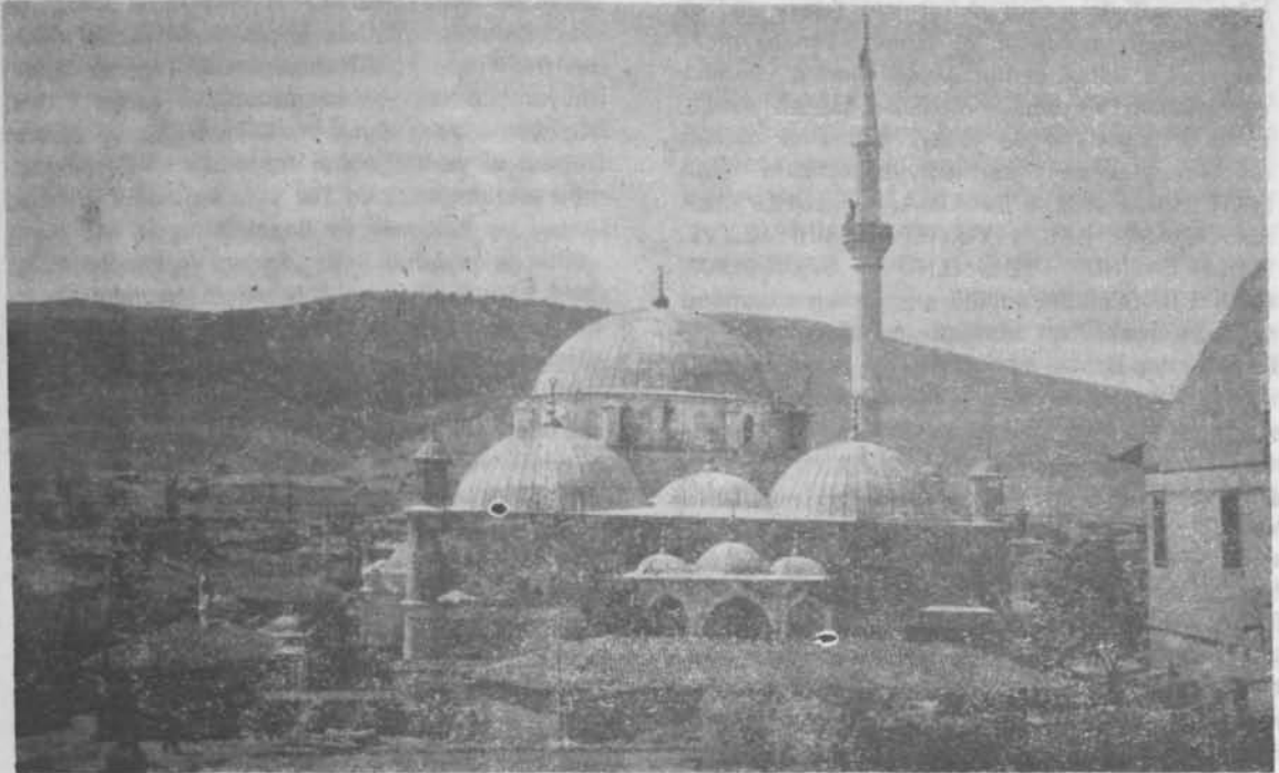
Câmi'nin onarımından sonraki durumu
