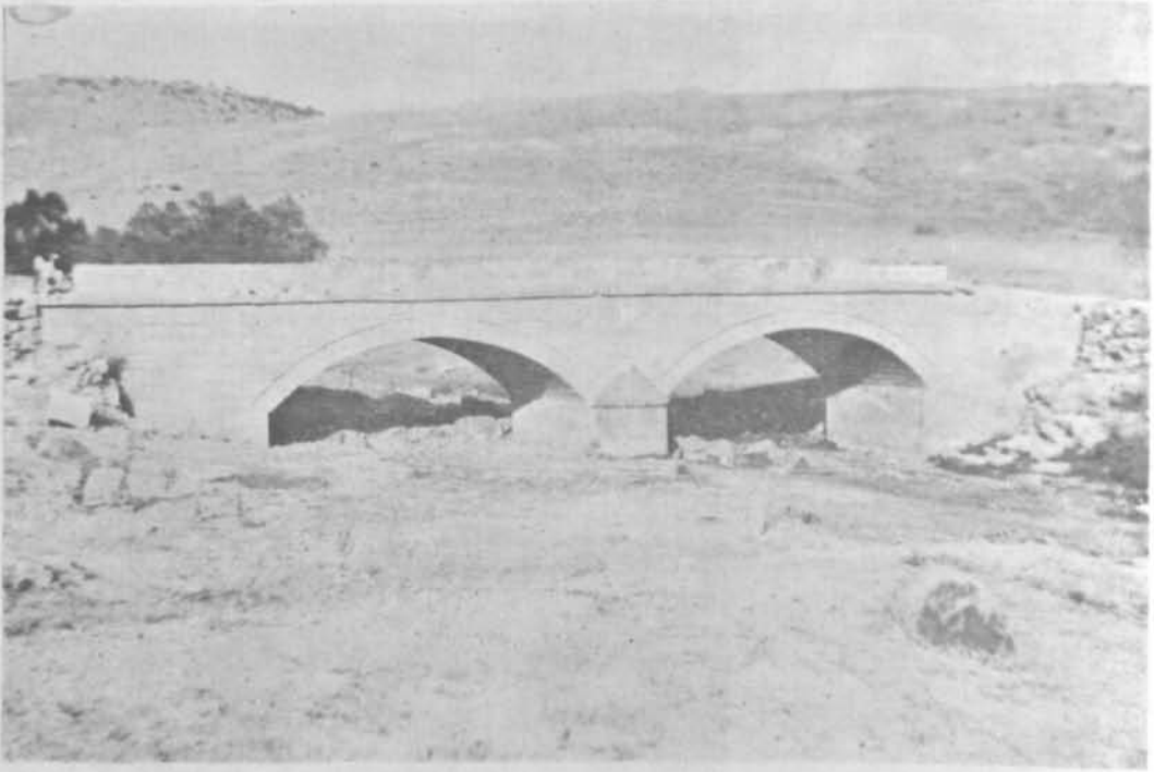
Resim 61 : Yozgat Şefaati yolu üzerinde bir köprü
