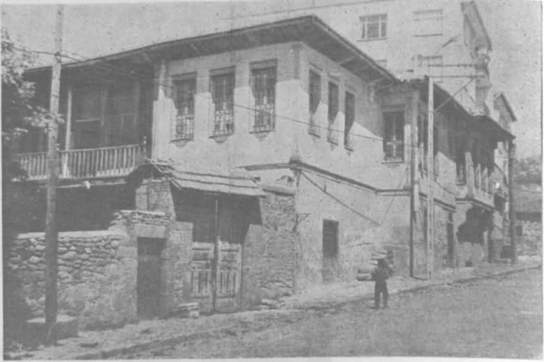
Resim 65 : Yozgat Nizamoğlu Konağı
