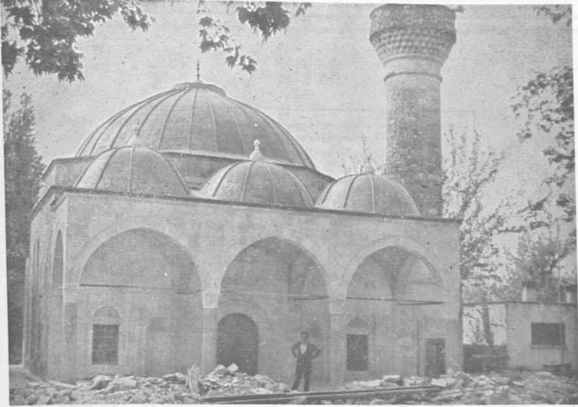
Resim : 16 Antalya Kaş Kasaba Köyü Camii, kuzey görünüş restorasyon sonrası
