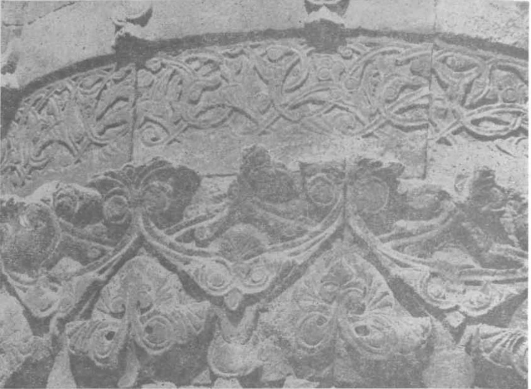
Resim. 16 Sivas Sahip Ata medresesi Batı duvarı Kuzey desteği kabartmaları
