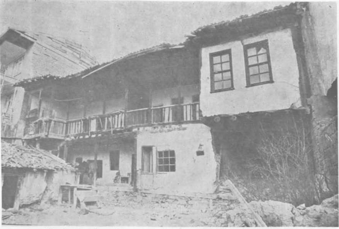
Resim 28 : Metruk evin avlu cephesi
