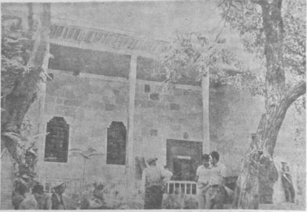
Resim 1 : Yozgat Osmanpaşa Köyü Camii'nin Doğudan Görünüşü
