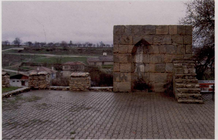
Resim 30: Zonguldak, Safranbolu Namazgahı, ön cephe.
