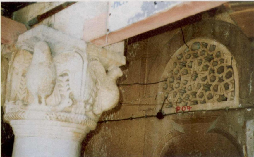
Resim 6: Avlunun çevresini kuşatan odaların kapı üzerine yerleştirilmiş pencere kafesleri.
