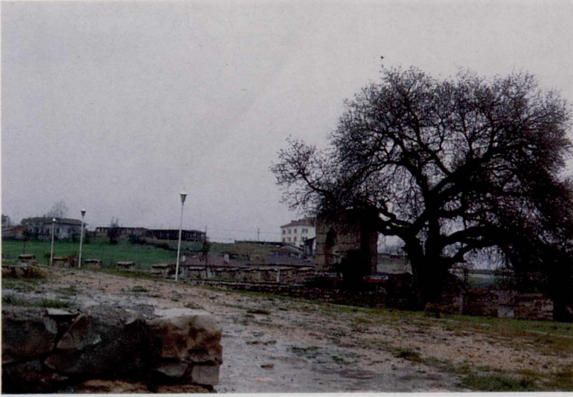
Resim 29: Zonguldak, Safranbolu Namazgahı, genel görünüm.
