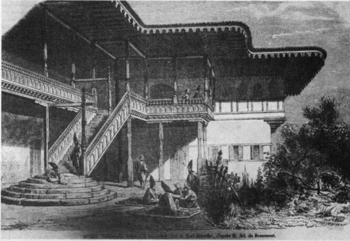
Resim 22: Trabzon'da Ahmet Bey Konağı (gravür).
