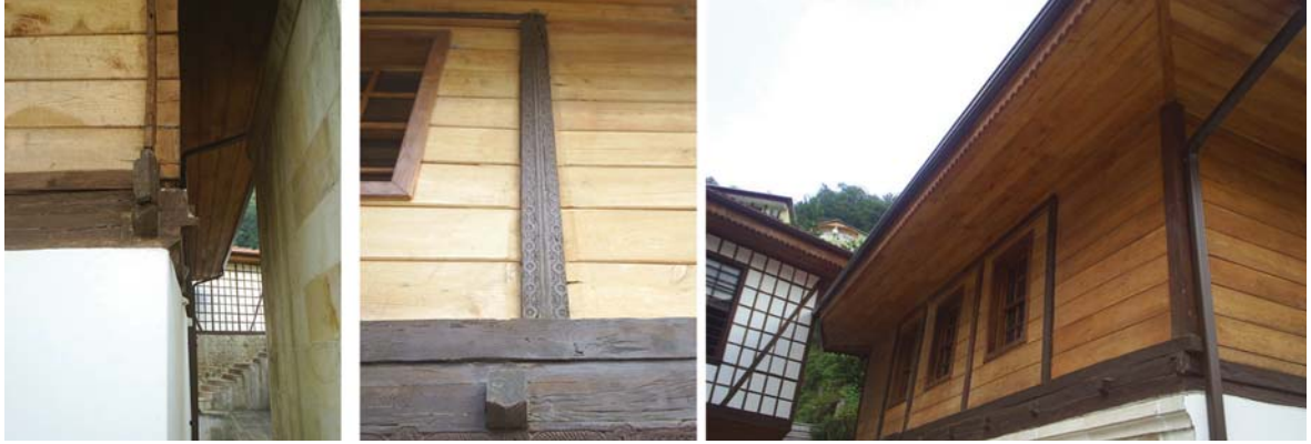
Resim 3: Boğaz geçme ahşap duvarlar
