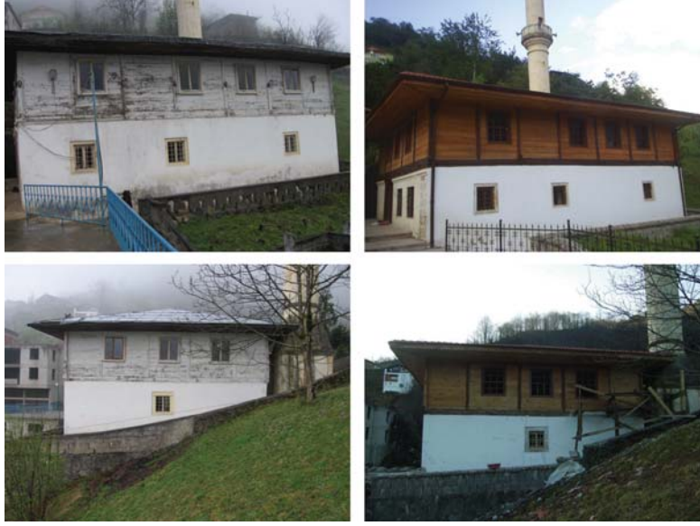
Resim 14 Onarım öncesi ve sonrası duvarlar
