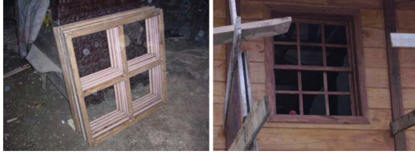
Resim 17: Pencere doğramalarının yenilenmesi
