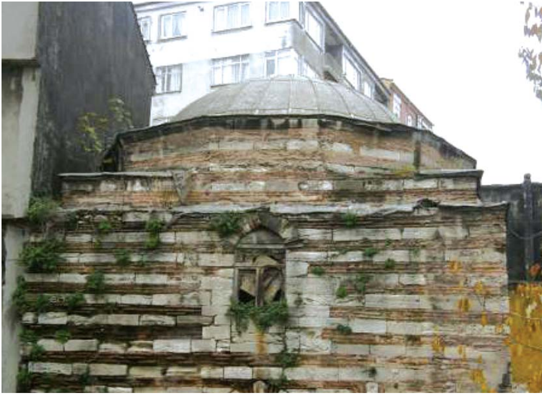
Resim 16: Kötü durumdaki kurşun saçak, bitkilenmeler ve mukarnas geçiş
