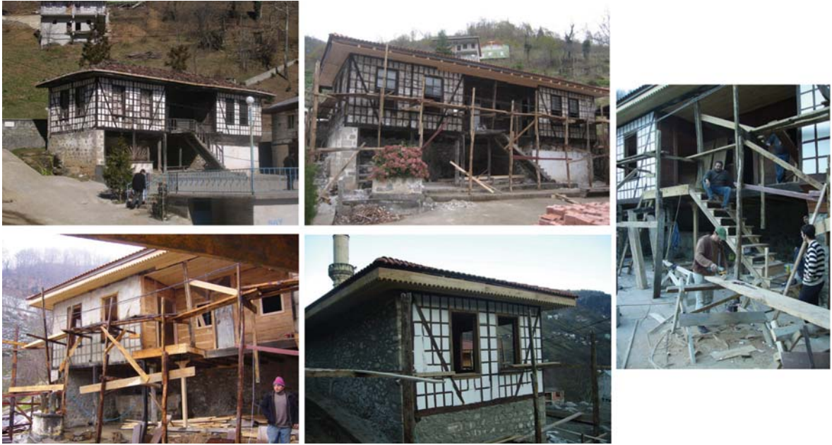
Resim 15: Medrese binasının duvarlarının onarımı
