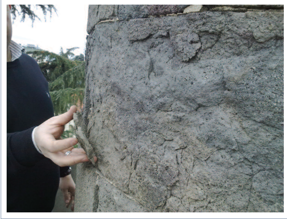
Resim 3. Minarede şerefe üzeri bozuk taşlar.
