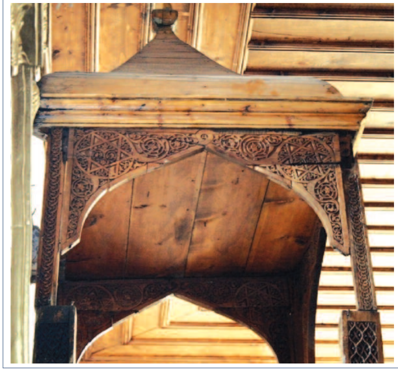
Resim 20: Minberin köşk çardağında tamir izleri.
