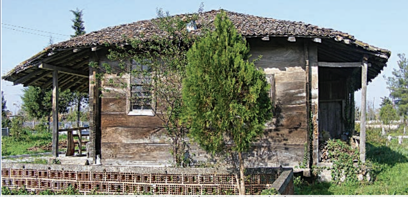
Resim 2: Ustacalı Köyü Camii'nin güney cepheden görünümü
