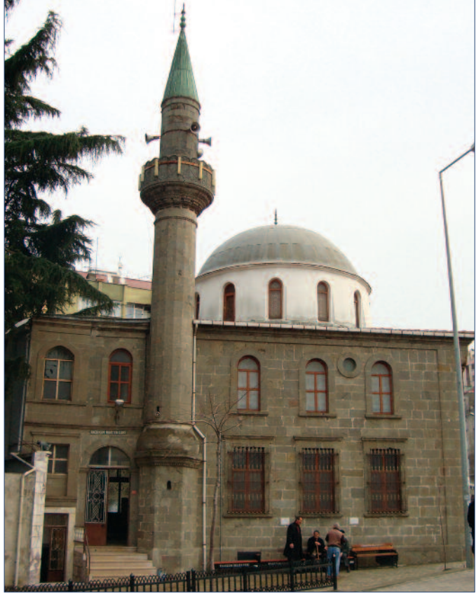
Resim 2. Hacı Kasım Camii batı cephesi ve minarenin görünüşü.
