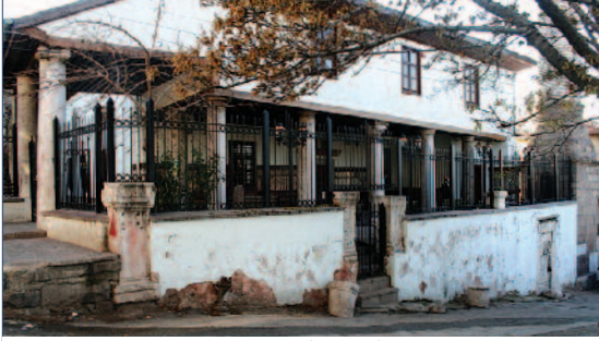
Resim 34: Caminin kuzeyden görünüşü.
