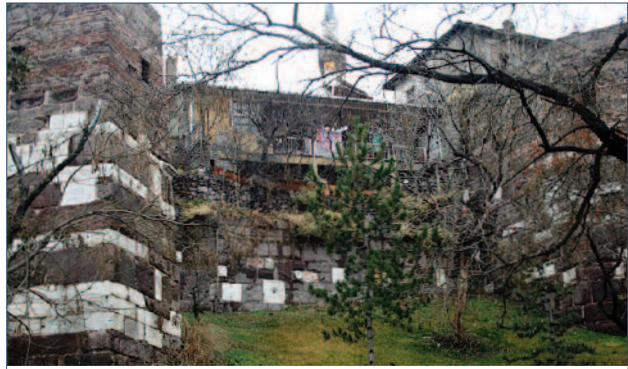
Resim 32: Sarayın cümle kapısının bulunduğunu tahmin ettiğimiz batı cephesi
