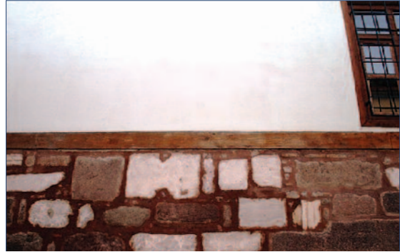
Resim 36: Harim ile son cemaat yerinin birleşme noktasında derzler.
