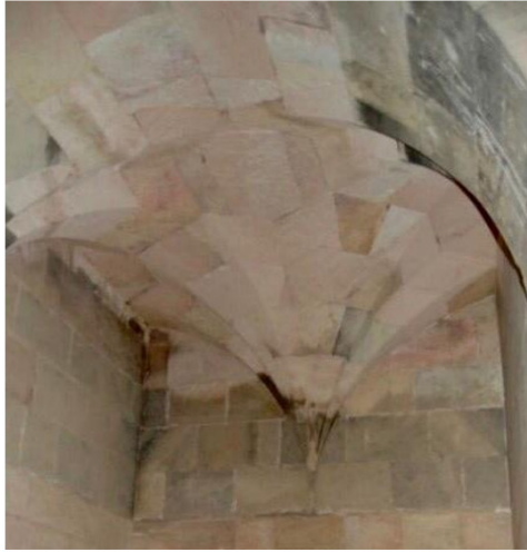
Resim 14. Divriği Şifhanesi 180° açılı kenar tonozu.
