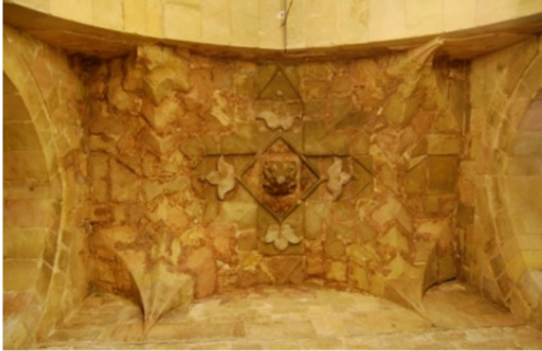
Resim 12. Divriği Ulu Cami 180° açılı kenar tonozu.
