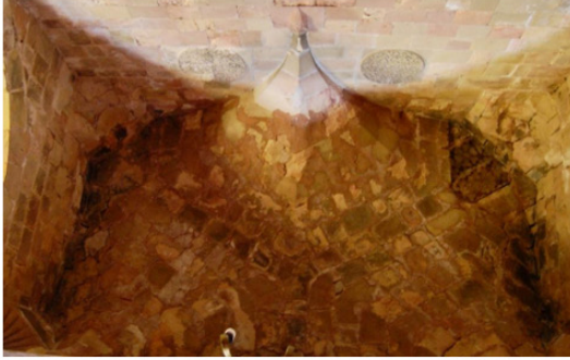
Resim 11. Divriği Ulu Cami 180° açılı kenar tonozu.
