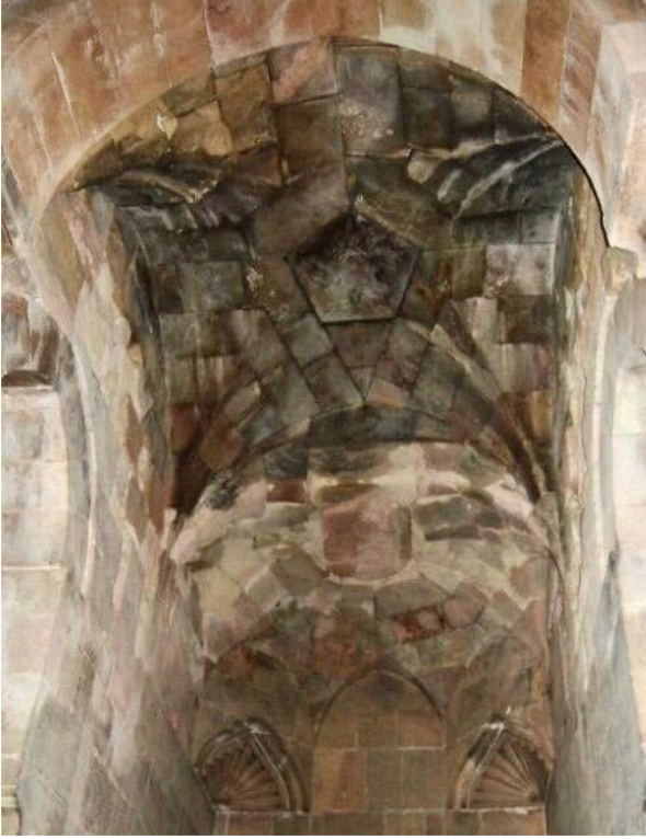
Resim 4. Divriği Şifhanesi kuzey eyvan iki kenarlı tonozu.
