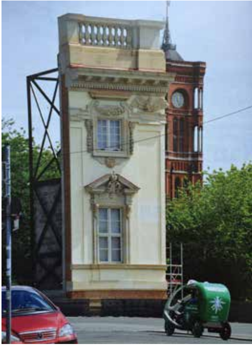
Resim 14. Berlin'de yeniden yapımı planlanan eski kral sarayının, kamuoyu bilgilendirme amaçlı yapılan 1/1 ölçekli cephe kesit prototipi.
