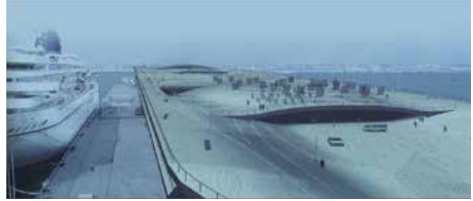
Resim 2. Yokohama Terminal Binası.
