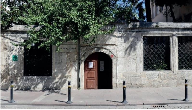
Şekil 43. Hacı Selim Ağa Kütüphanesi'nin bahçe duvarı
