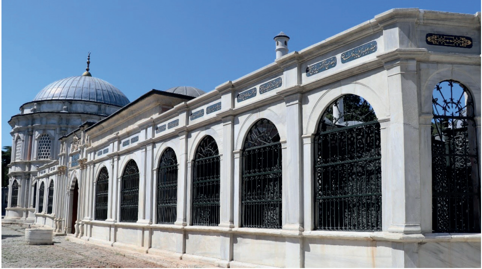
Şekil 108. İmâret duvarındaki hâcet pencereleri üzerindeki kitâbelerin genel görünümü
