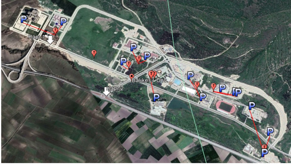
Şekil 4. Kampüs otopark ve trafo merkezlerinin genel görünümü.
