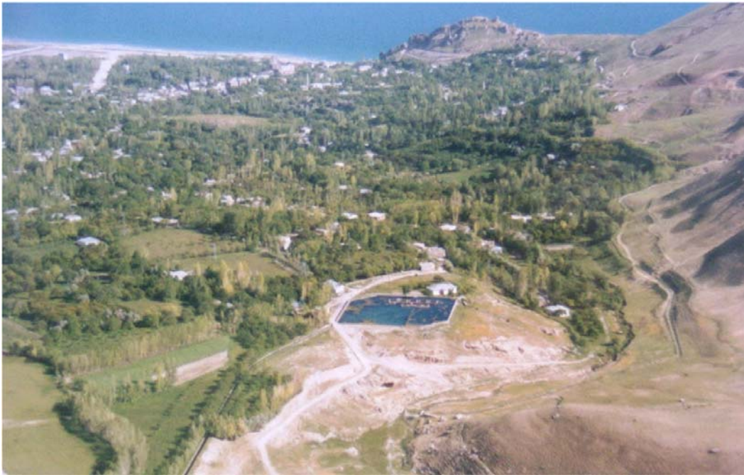
Şekil 1. Adilcevaz Hidroelektrik Santrali yükleme havuzu
