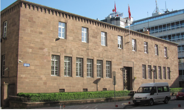
Görsel 22: T.C. Merkez Bankası Samsun Şubesi binası ana cephe genel görünümü (E. Kolay, 2017)
