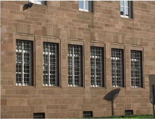
Görsel 24: T.C. Merkez Bankası Samsun Şubesi binası pencere açıklıkları (E. Kolay, 2017)
