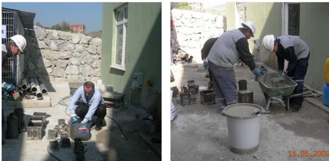
Şekil 2.1.Şantiyede Beton Küp Numune Alma
