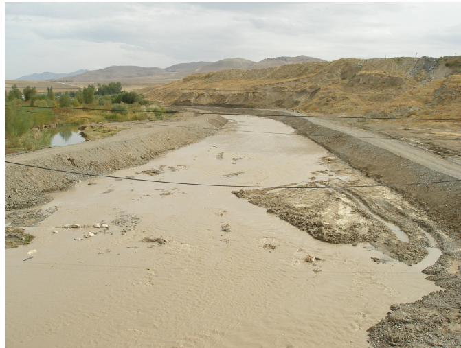
Şekil 12. Karasu Çayı üzerinde bulunan Ablangaz Köprüsü mevkiinin ıslah çalışmasından sonraki (12.10.2006) hali (Fotoğraf: Mahmut Elp).
