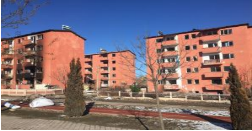
Şekil 6. Karşıyaka Mahallesi Yıkılmayı Bekleyen Binalar (Elazığ Belediyesi, 2021).
