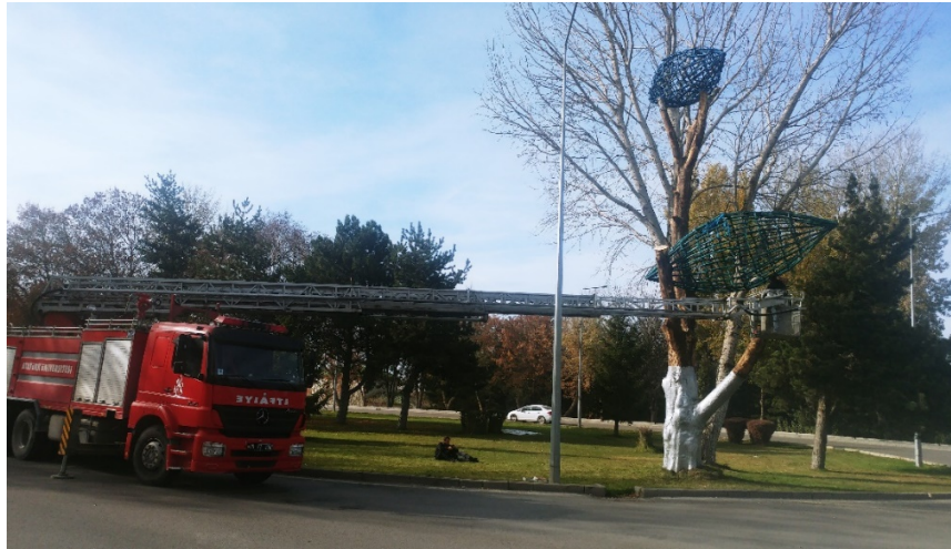
Resim 14. İkinci Formun Yerleştirilme Anı, 2019
