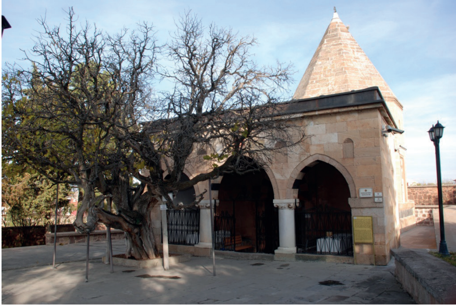
Ek 1: Hacıbektâş Pir Evi'nin Avlusundaki Kutsal Dut Ağacı
