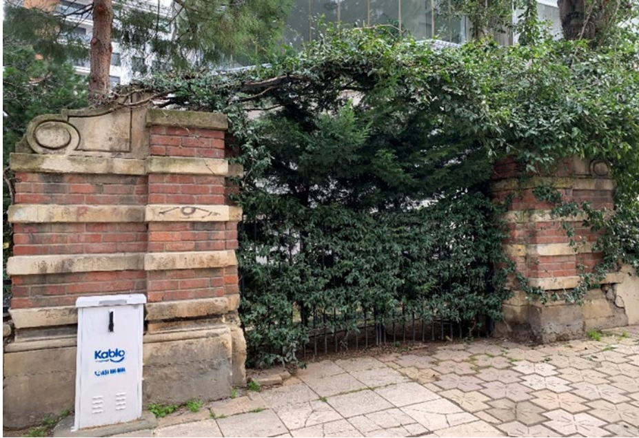
Şekil 10: Fuad Paşa Caddesi üzerinde bulunan bahçe kapısı
