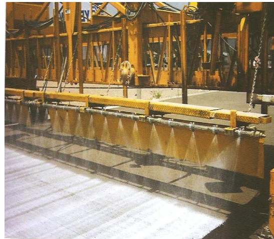
řekil 7. Beton yzeyinin enine przlendirilmesi řekil 8. Beton yzeyine kr kimyasalının uygulanması
