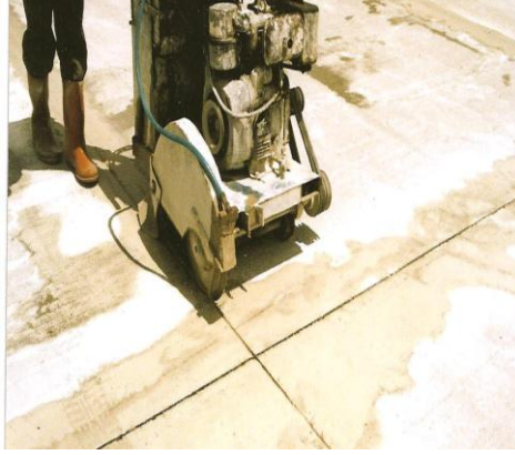
Şekil 9. Derzlerin genişletilmesi ve pah açılması
