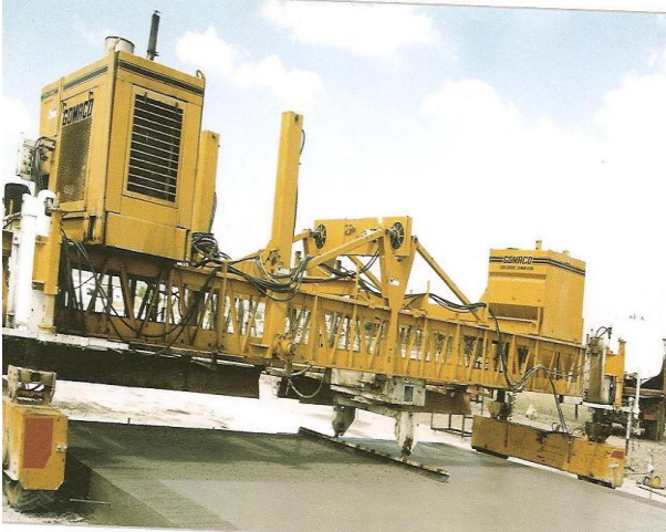
řekil 7. Beton yzeyinin enine przlendirilmesi řekil 8. Beton yzeyine kr kimyasalının uygulanması
