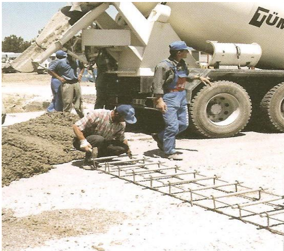
Őekil 5. Betonun, finiřer önüne boşaltılması ve serilmesi
