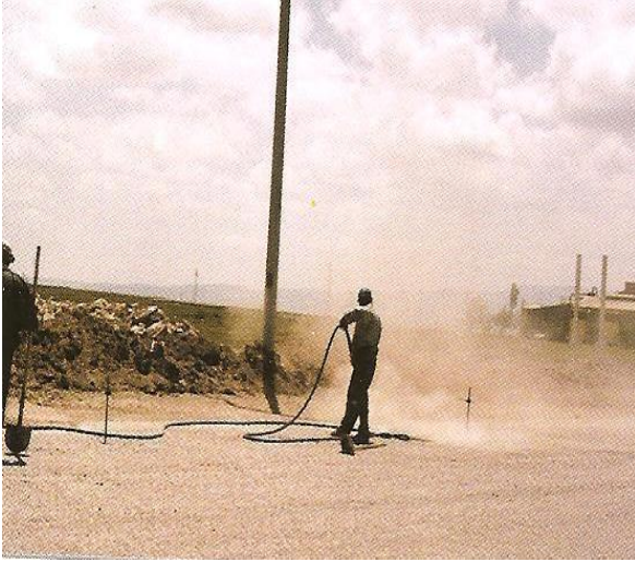
Őekil 3. Yol yüzeyinin tozdan arındırılması
