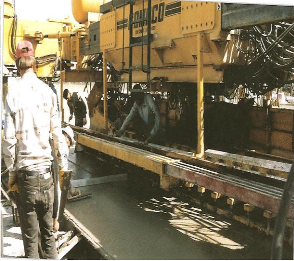
řekil 6. Beton, finiřerin arkasından kalıplanmıř olarak ıkmadı ve yzeyi iřiler tarafından dzlenmesi
