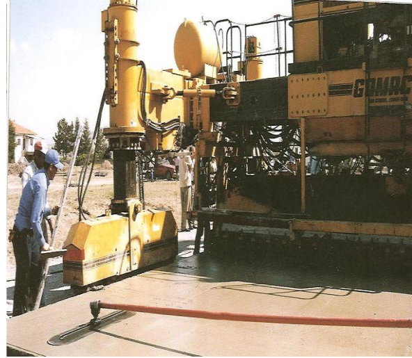
řekil 6. Beton, finiřerin arkasından kalıplanmıř olarak ıkmadı ve yzeyi iřiler tarafından dzlenmesi
