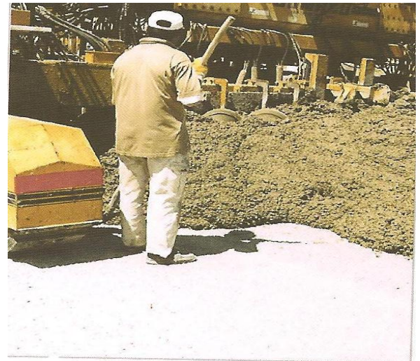
Őekil 5. Betonun, finiřer önüne boşaltılması ve serilmesi
