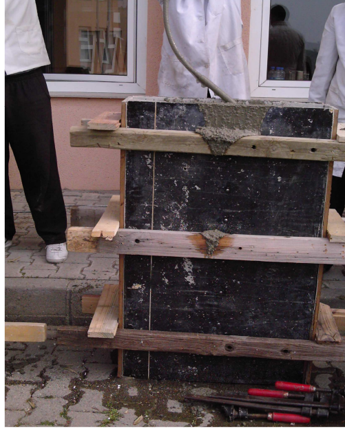
Şekil 1. Kalıba beton dökümü ve vibrasyon uygulaması
