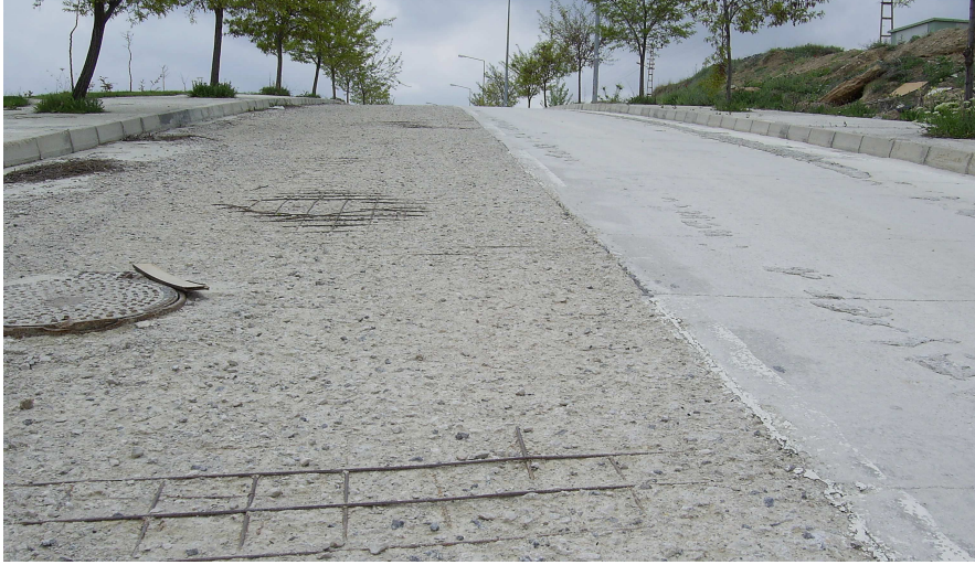
Şekil 5. Türkkonut Ankara Çayyolu-1 Uydu Kent Projesi beton yol uygulaması [8]
