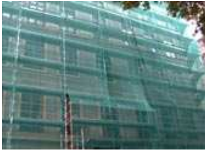
Şekil 2. İnşaat tekstillerin, iskele ağları ve ince saydam çatı olarak kullanılması [9]
