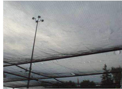
Şekil 2. İnşaat tekstillerin, iskele ağları ve ince saydam çatı olarak kullanılması [9]
