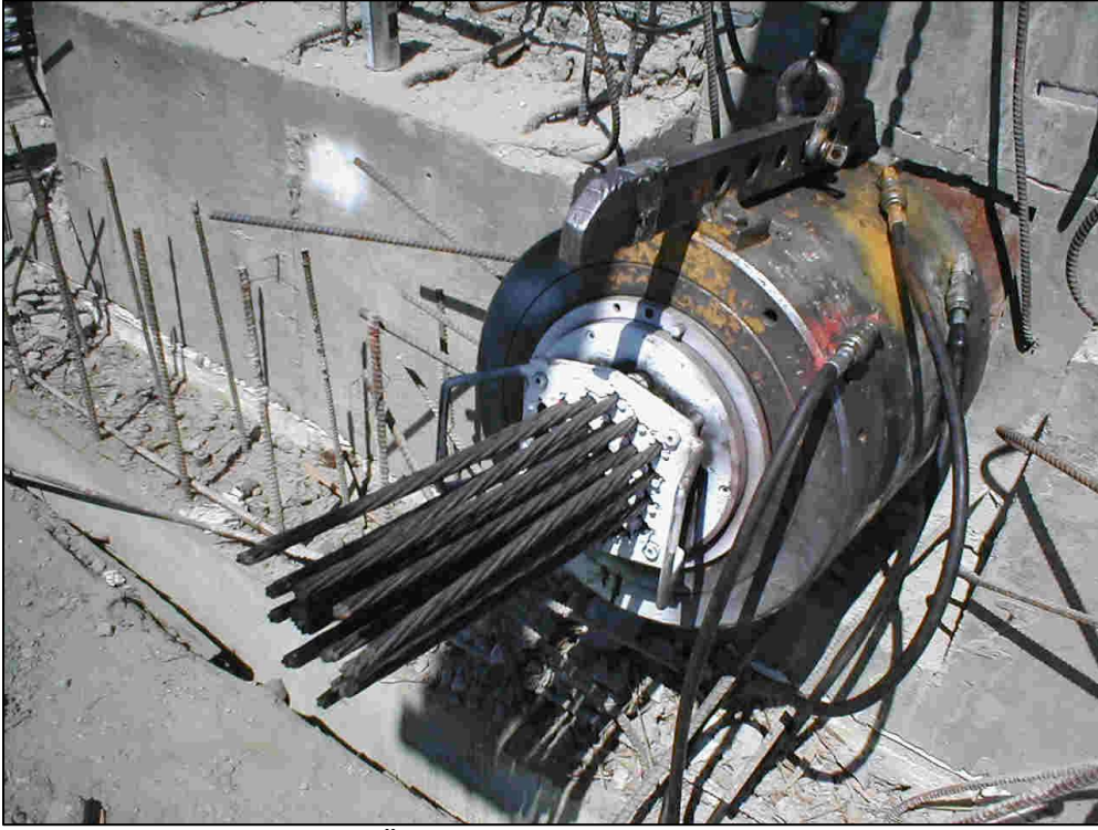
Şekil 11. Öngerilme donatılarının çekilmesi
