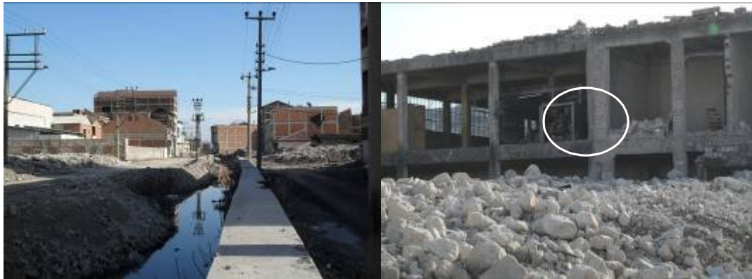
Şekil 4,5. Çalışma alanının mevcut durumu ve atıl sanayi makinelerinden görünüm
