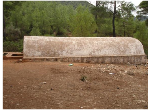
Foto. 8: 4 Nolu Sarnıç, Yan Cephe.
