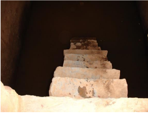
Foto. 7: 3 Nolu Sarnıç, Merdivenler.
