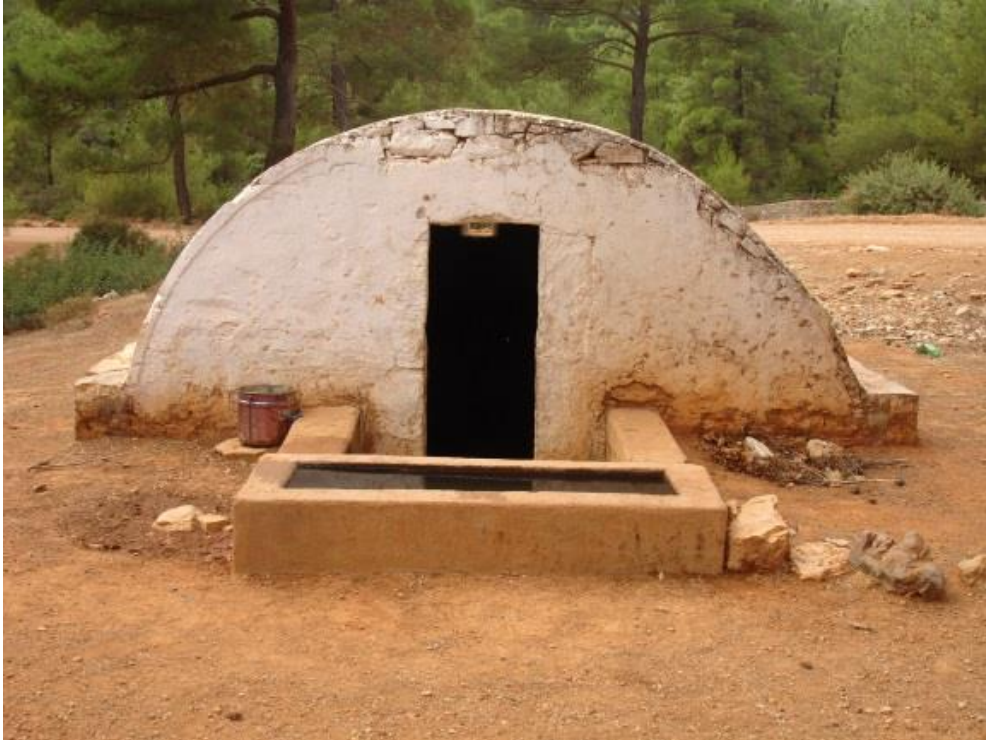
Foto. 9: 4 Nolu Sarnıç, Giriş Cephesi.
