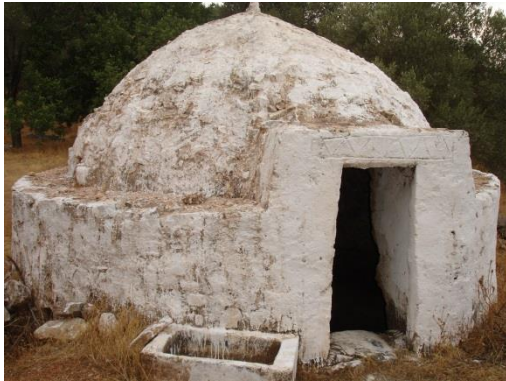
Foto. 1: 1 Nolu Sarnıç Genel Görünüş.
