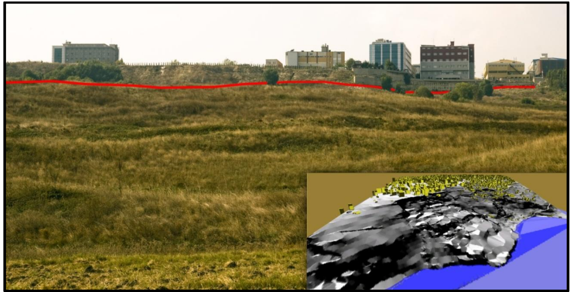
Şekil 4. Aktif Firuzköy heyelanının genel görüntüsü (topuktan taca doğru bakış). Figure 4. A general view from heel to scarp of the active Firuzköy Landslide.
