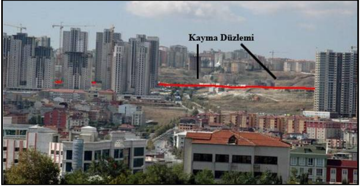
Şekil 7. Kıracağı'nın batısında aktif olmayan (eski) heyelanlı alanlar üzerine yapılan yüksek katlı yapılar.
