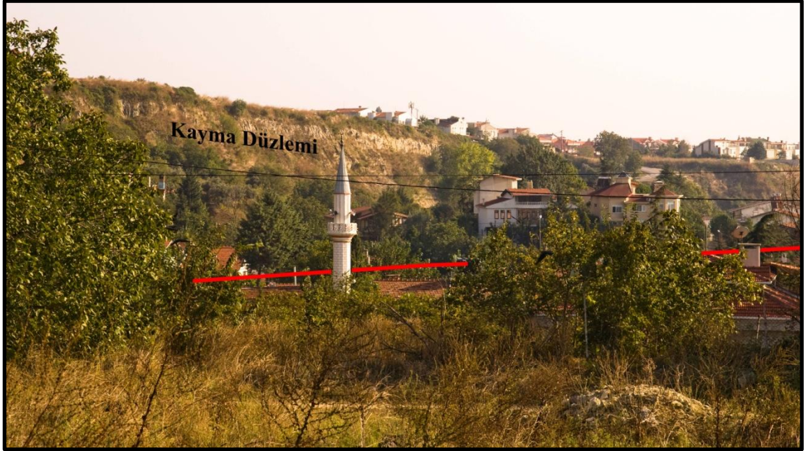
Şekil 6. Kısmen Aktif Pekmez heyelanının taç kısmından bir görünüm. Figure 6. A view of scarp of the partially active Pekmez Landslide.
