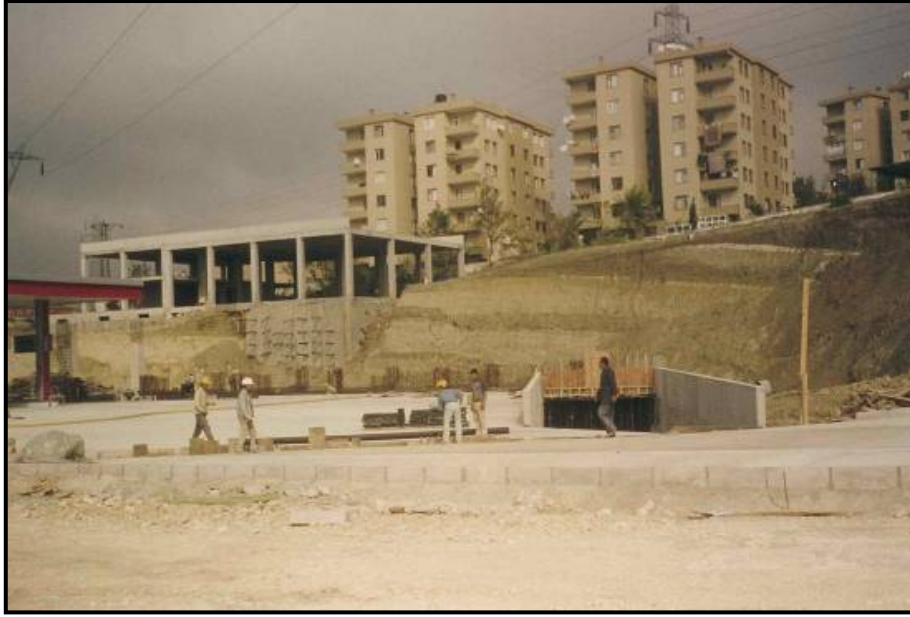
Şekil 12. Avcılarda faylanmaya bağlı olarak bina temelinde oluşan şev kaymasının iyileştirilmesi Figure 12. Depending on the building on the basis of fault to be the improvement of the slope shift, in Avcılar
