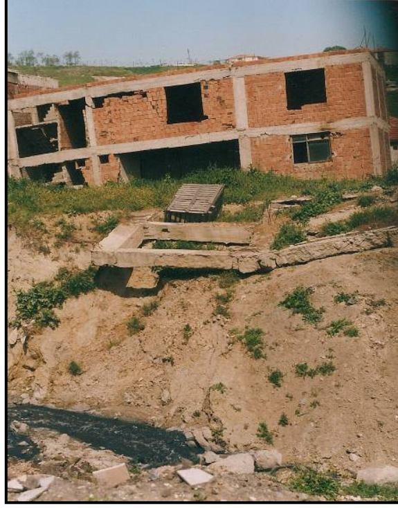
Şekil 8. Kıraç'ta heyelanın taç kısmının yüklenmesi sonucu binada oluşan deformasyon Figure 8. Deformation in the building caused by loading the landslide's crown
