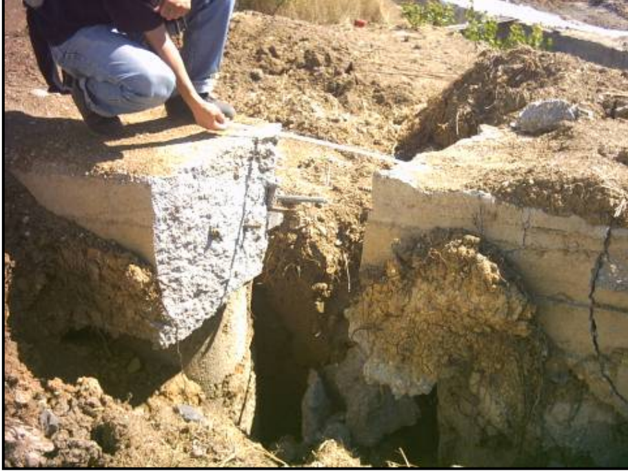
Şekil 18. Hadımköy dolayında fabrika temel kazısı sırasında kazık başlığının yenilmesi Figure 18. Defeated pile head during the plant foundation excavation
