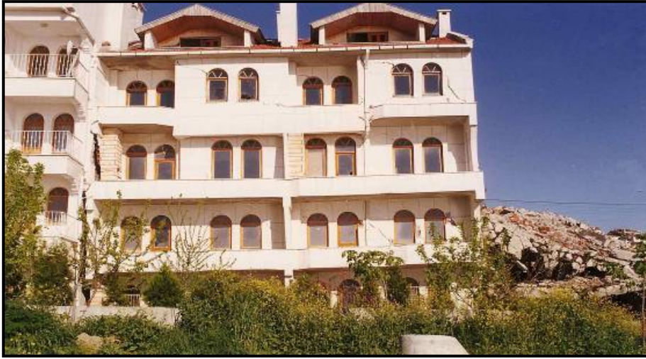
Şekil 9. Pekmez dolayında heyelan olayına bağlı olarak oluşan bina hasarı Figure 9. Building damaged by landslide near Pekmez
