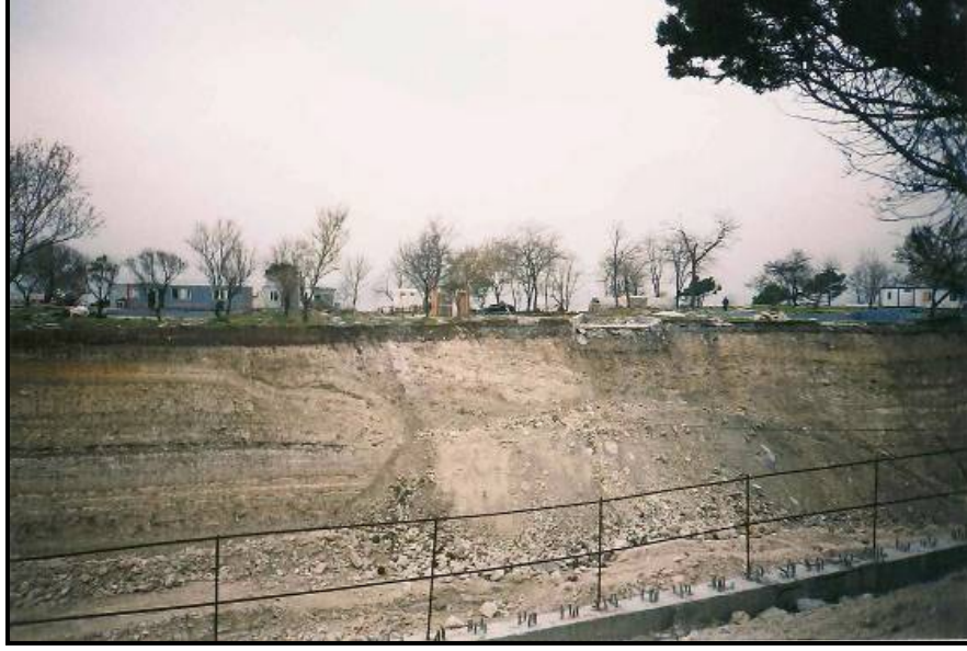
Şekil 11. Bakırköy formasyonunda faylanmaya bağlı şev duraysızlıkları Figure 11. Slope stability originated from faulting in the Bakırköy formation
