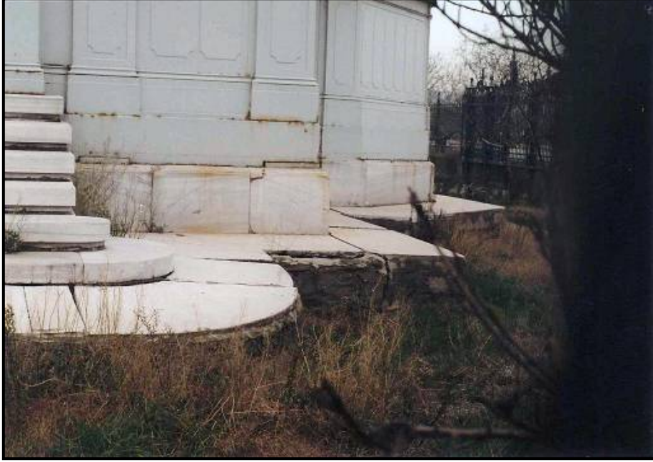
Şekil 15. Haliç çevresindeki Bulgar Kilisesi'nin bahçesinde oluşan oturmalar Figure 15. Settlement in the garden of the Bulgarian Church on the Golden Horn
