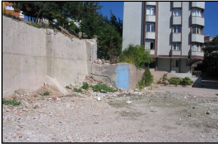
Şekil 7. Avcılar Balabanda heyelan sonucu yıkılan ve düşeyden sapan bina Figure 7. The building collapsed and deviated from the vertical due to landslides, in Avcılar, Balaban
