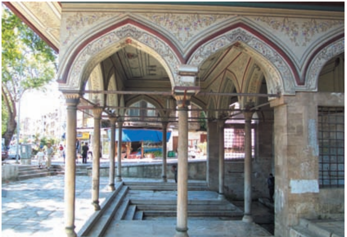
Resim: 14 Güney görünüşü, 2002
