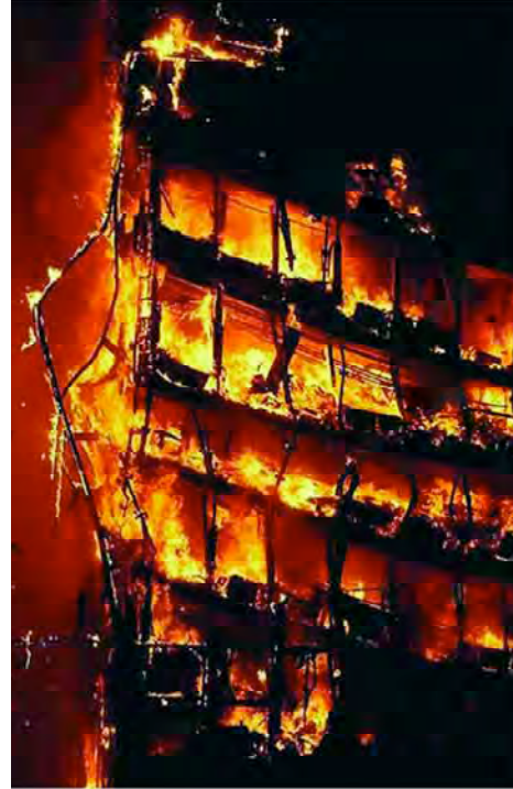
Resim:1 Windsor Binası Yangını, Madrid, 12 Şubat 2005 (Anonim, 2005)
