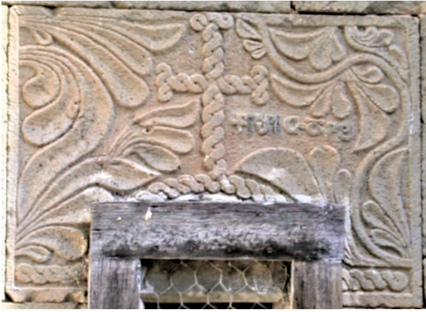
Fig. 54. Parhali Kilisesi, batı cephe, güneydeki pencere
