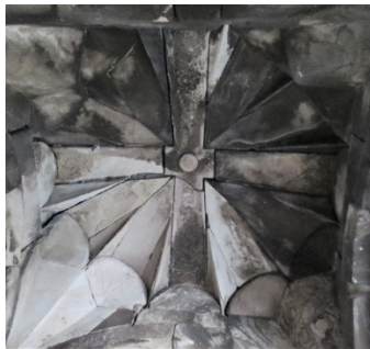
Fig. 76. Oşki Kilisesi, batı haç kolunun güneyindeki mekân, yıldız tonoz
