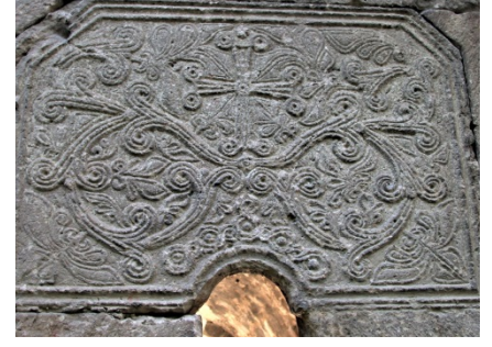
Fig. 64. İşhani Kilisesi, doğu cephe, kuzey uçtaki pencere
