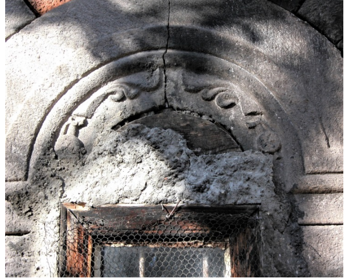
Fig. 53. Hahuli Kilisesi, doğu cephe, apsis penceresi
