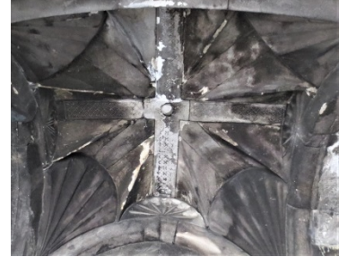
Fig. 75. Oşki Kilisesi, batı haç kolunun güneyindeki mekân, yıldız tonoz
