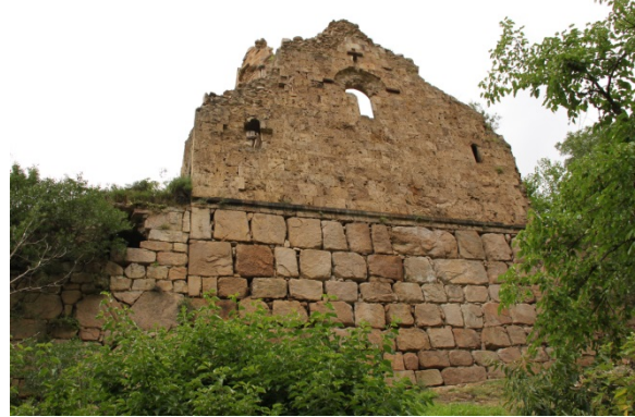
Fig. 2. Handzta Manastırı Kilisesi, doğu cephe
