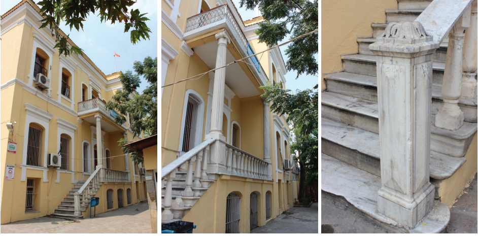
Görsel 11-12-13: Konağın Kuzey Cephesi ve Merdiven Detayı
