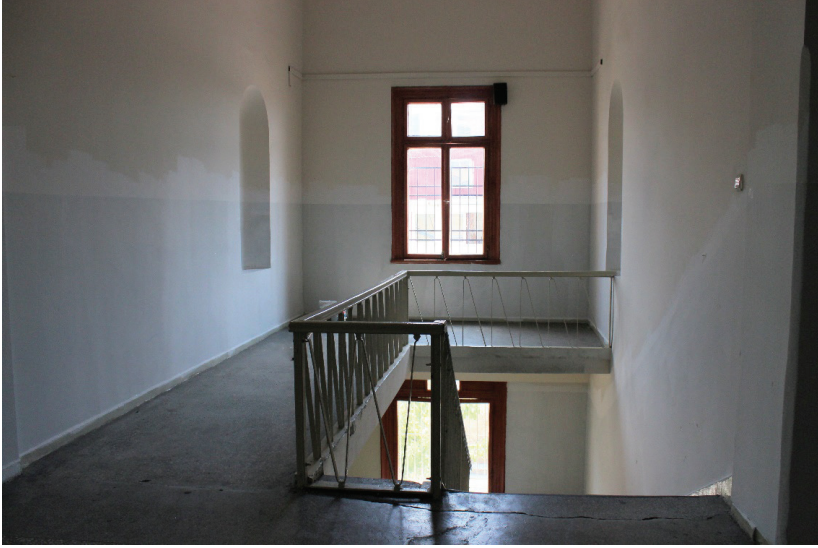
Görsel 6: Birinci Kat Merdiven Bölümü
