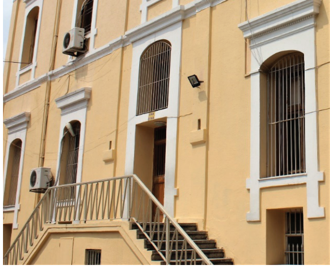
Görsel 15: Doğu Cephedeki Giriş Bölümü
