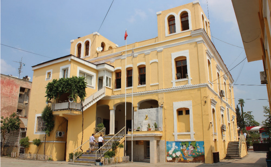
Gör. 10: Konağın Güney Cephesi
