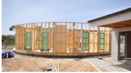
Şekil 19. Yapının ahşap strüktürü (URL 11)
