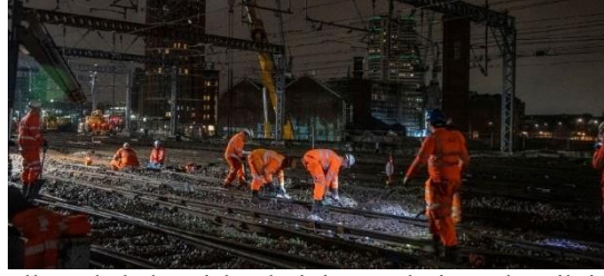
Şekil 4. Modern demiryollarında bakım işlemlerinin geceleri yapıma ihtiyacına dair bir örnek [43]
