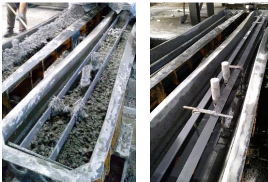
Şekil 3. Yeni geliştirilen 30-VRTC-SND (sol) ve 30-SND tipi (sağ) L-CFRPU donatılı betonarme demiryolu traverslerinin üretimleri esnasında alınan örnek görseller
