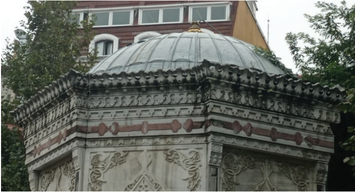
G. 26: Keçecizade Fuad Paşa Türbesi'nin kubbesi (Fatih Sarımeşe, 2021)
