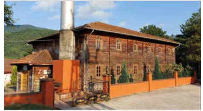
Fotoğraf 7. Batı cephe / Western facade.
