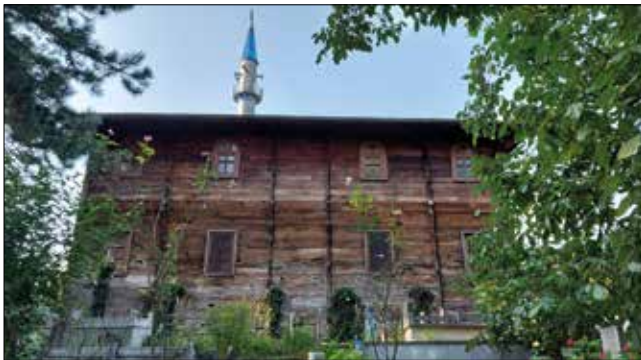
Fotoğraf 5. Güney cephe / Southern facade.
