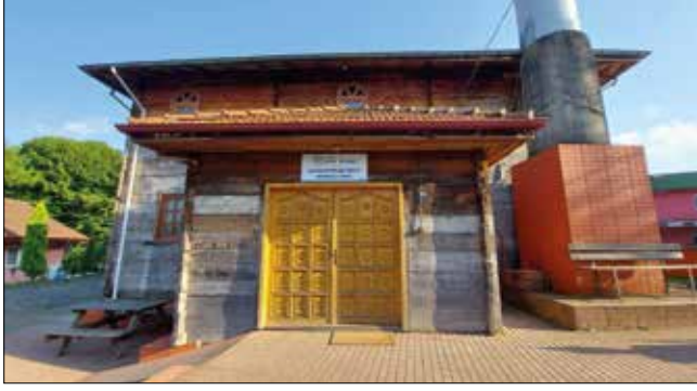
Fotoğraf 8. Kuzey Cephe / Northern facade.
