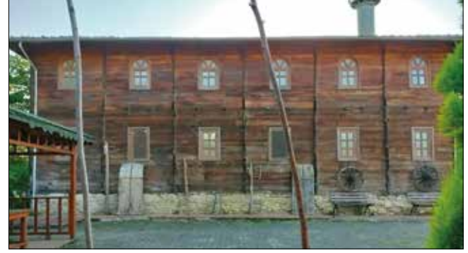
Fotoğraf 6. Doğu cephe / Eastern facade.
