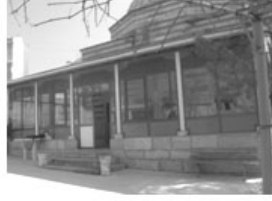
Şekil 29. Şeyh Çelebi Camii'nin son cemaat mahallinin eğimli sundurma ile kapatılması (Orijinal, 2006)
