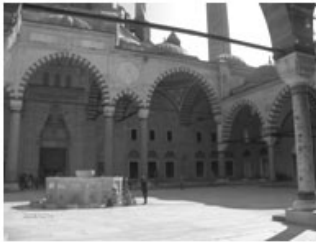
Şekil 21. Selimiye Camii Görünüşü, Orijinal, 2005
