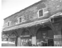
Şekil 28. Rüstempaşa Kervansarayı, ön cephesindeki ticari kullanım (Orijinal, 2006)
