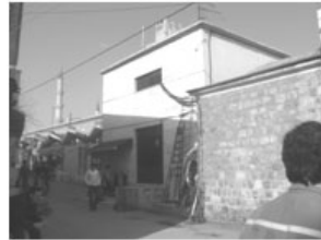
Şekil 41. Ali Paşa Çarşısı Ota Kapı'nın Arkasında yaklaşma sınırı gözetilmeksizin yer alan trafo binası (Orijinal,2006)
