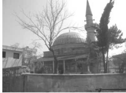
Şekil 25. Şeyh Çelebi Camii Görünüşü (Orijinal, 2006)
