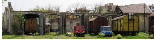
Resim 5. Çerkezköy Lokomotif Deposu Giriş Cephesi
