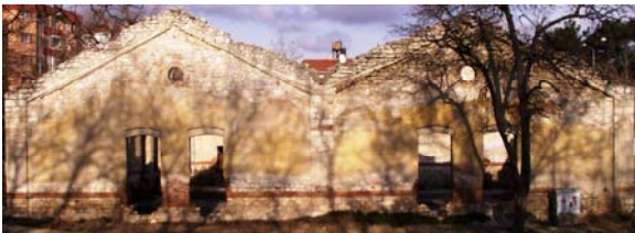
Resim 8. Kırklareli Lokomotif Deposu Sol Yan Cephesi
