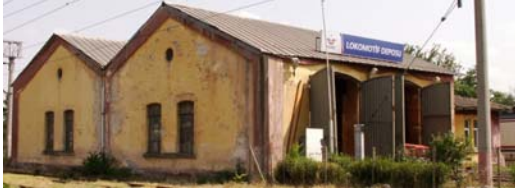
Resim 4. Alpullu Lokomotif Deposu Giriş ve Sol Yan Cephesi
