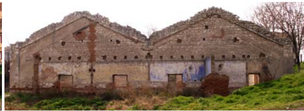
Resim 7. Kırklareli Lokomotif Deposu Sağ Yan Cephesi
