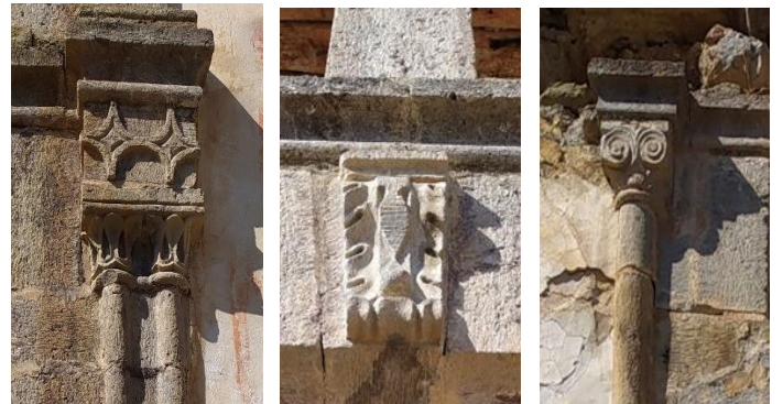
Şekil 6: a) Alt Sütunce Süslemesi b) Kilit Taşı Süslemesi c) Üst Sütunce Süslemesi
