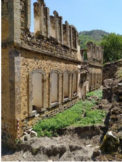
Şekil 10: Rum Erkek Okulu Güneybatı Cephesi Genel Görünümü
