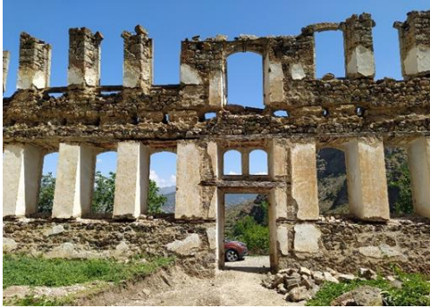
Şekil 11: Rum Erkek Okulu İç Mekânı Duvar Bölmesi İzleri
