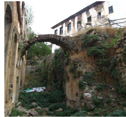
Şekil 9: Güneybatı Cephesi Köprü ve Merdiven Kalıntısı
