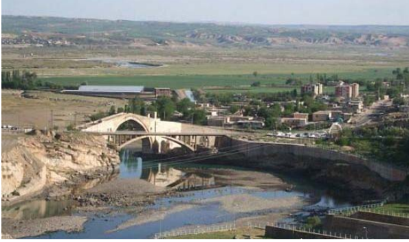
Foto 15. Betonarme (Tuğla) Mesken meskenlerin hakim olduğu: Çatakköprü Köyü
