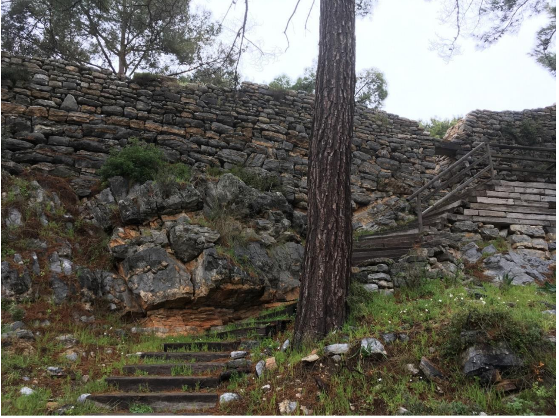
Resim 6: Akropolis: Sur duvarlarının dış yüzü
