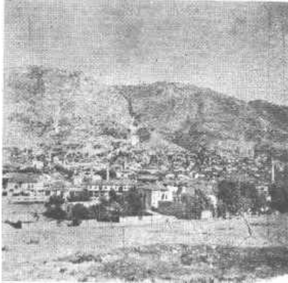
Resim 6 - Antakya'da Habip Neccar dağından inen bir selin basamaklar halinde düzenlenmiş yatağı (arkada). Böylece selin sararlar) önlenmiştir. Kuzeyden güneye doğru bakış. Resmin solu ortasında sağa doğru akan Asi nehri. (Foto : C. Alagöz Temmuz 1943),
