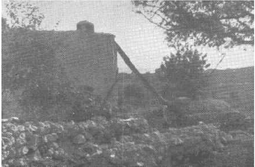
13 — Gürses'te damdaki yağmur sularını sarnıca boşaltan kanal
