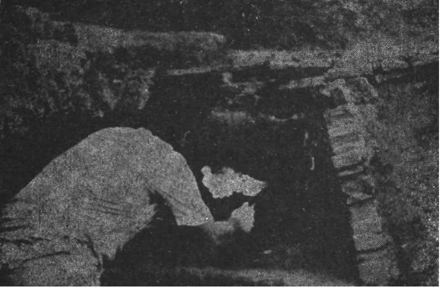
Resim 15 Fırın ateşhanesinin tamamlanan kısımlarının ıslendirilmesi (İznik Çini Fırınları-Bursa)
