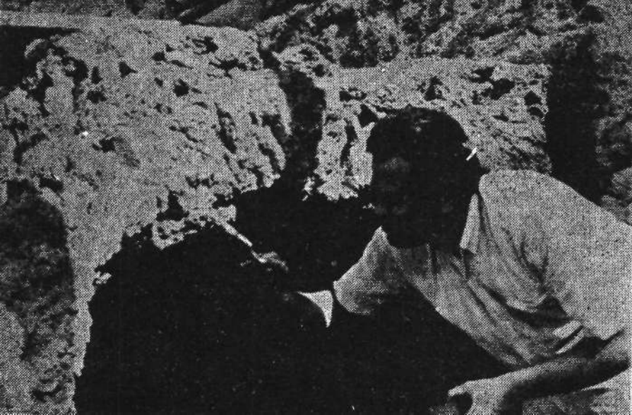
Resim 14 Ateşhaneye eriyikin fırçayla sürülerek içine emdirilmesi (İznik Çini Fırınları-Bursa)
