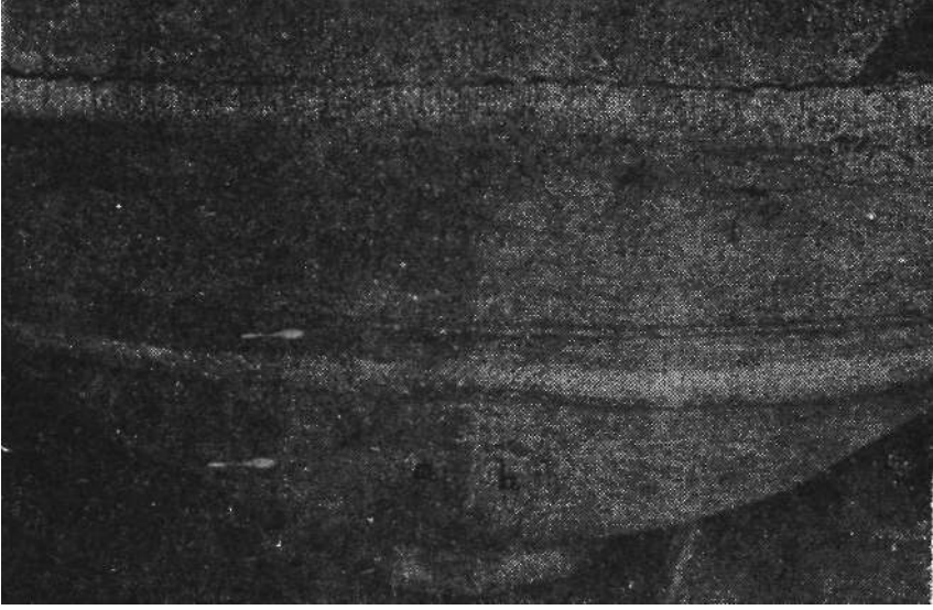
Resim 9 Kum püskürtme yöntemi (Perge-Antalya) a) Temizlenen kısım b) Temizlenmeyen kalker tortusu
