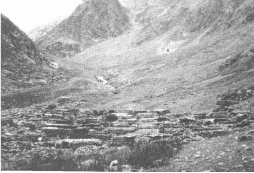
Foto 11: Vadi içerisinde kanalize olan rüzgârların olumsuz etkilerinden korunmak amacıyla bir eşik önünde kurulmuş olan Dübe yaylası. Yayladaki evler çoğunlukla tek oda olup morenlerden yapılmıştır.
