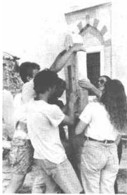
Resim 30 : Metal çubuk yerleştirilmiş parçaların yapıştırılması-Muradiye
