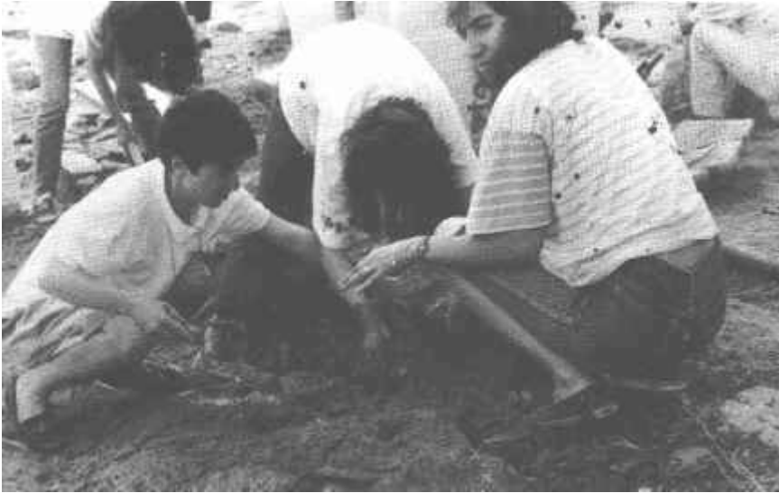
Resim 35 : Hazire duvarının onarımı-Muradiye
