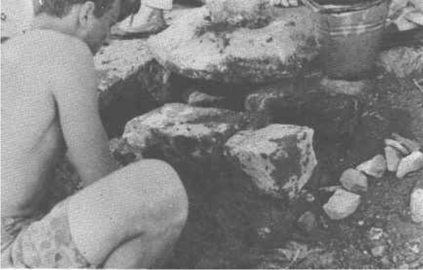
Resim 32 : Platform bloklarının yerine oturtulması-Muradiye
