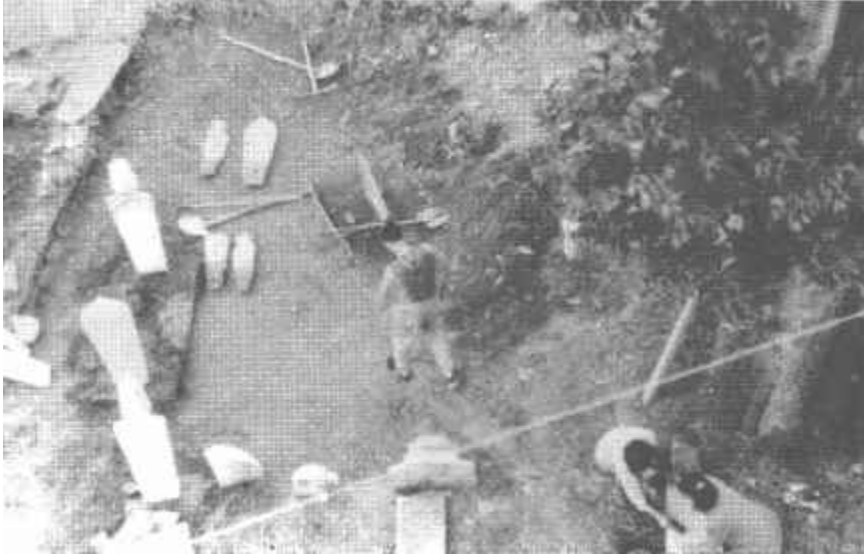
Resim 36 : Hazirenin onarım öncesi görünümü-Muradiye
