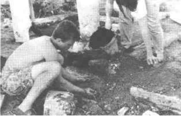
Resim 31 : Çökmüş platform bloğunun çıkartılması-Muradiye
